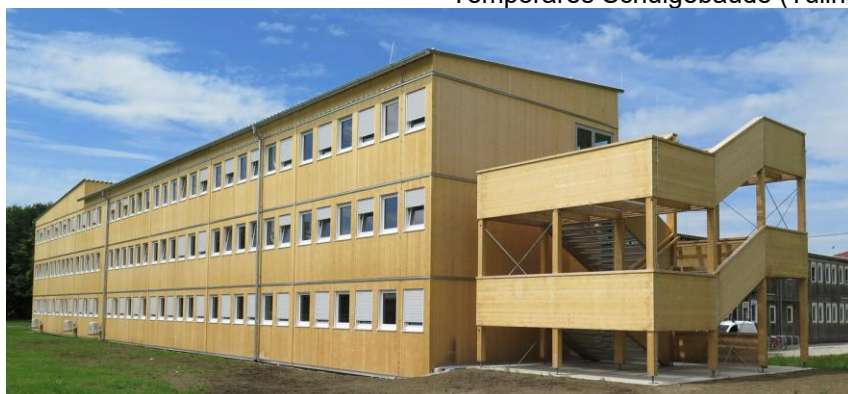
Abbildung 19 Temporäres Schulgebäude (Tullnerbach) © Schmid Holzbau GmbH
