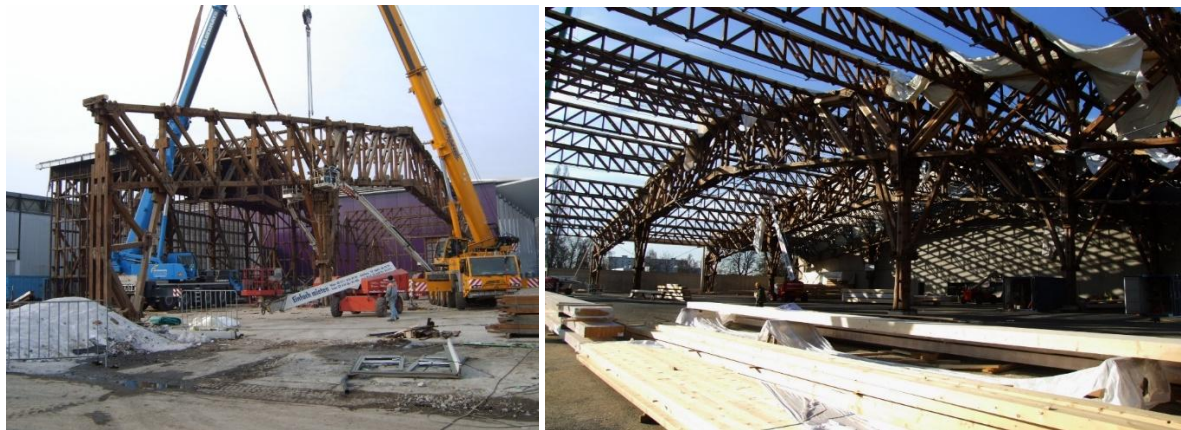
Abbildung 12 Rückbau Halle 11 Messe Graz © Graf-Holztechnik GmbH
