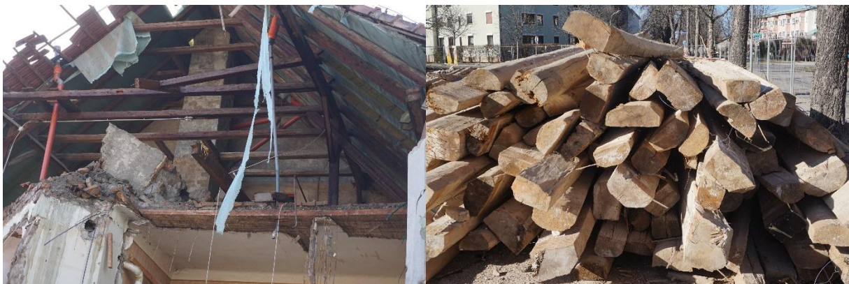
Abbildung 1: Altes Massivholz während (links) und nach dem Abbruch (rechts)
