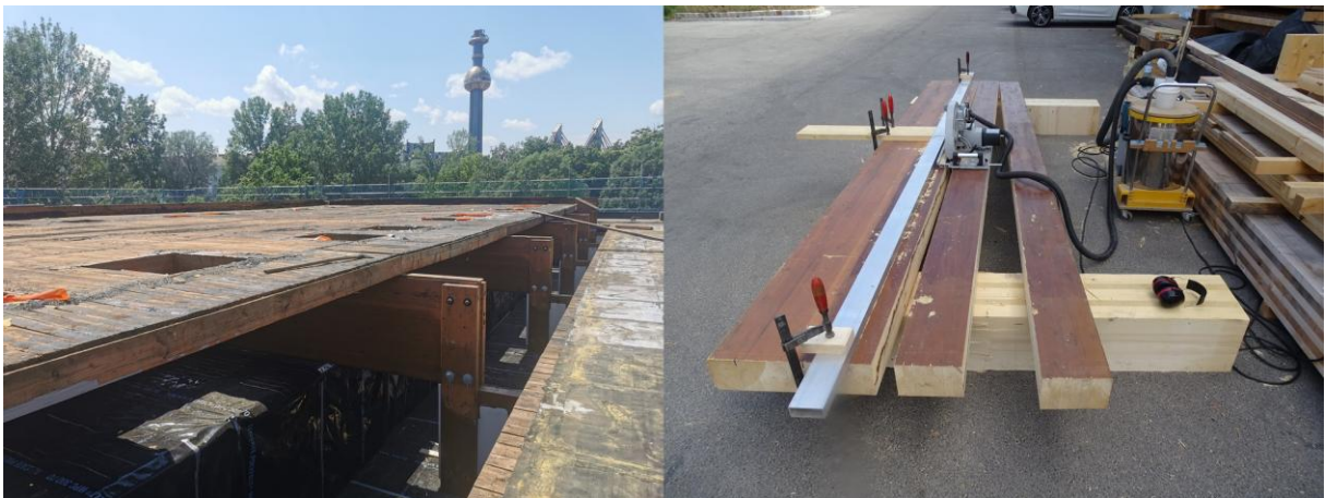
Abbildung 2: Alte Brettschichtholzträger im Bestand (links) und herausgetrennte Abschnitte für die Bauteilprüfungen (rechts)
