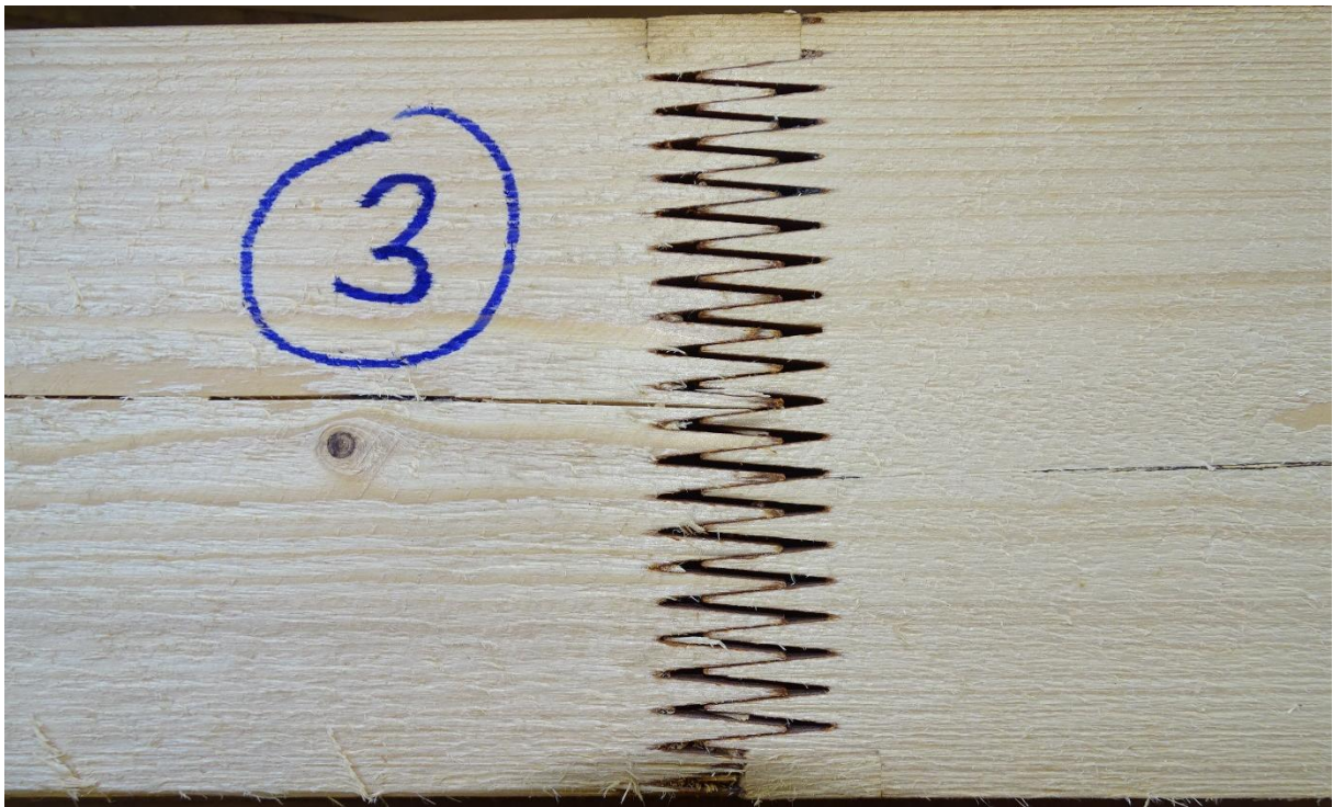
Abbildung 23: Fehlverklebte Keilzinkung eines geprüften Brettschichtholzabschnitts
