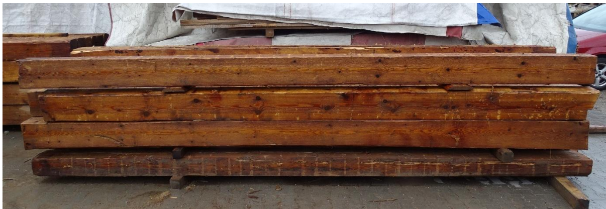
Abbildung 5: Gemäß DIN 4074-1 sortierte Kantholzbalken aus abgebrochenen Gründerzeithäusern
