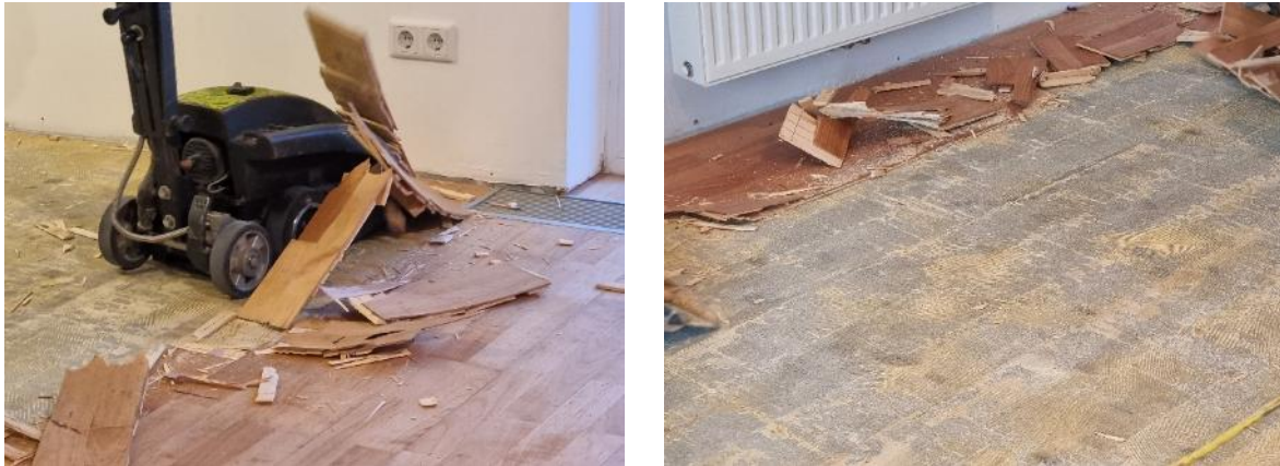
Abbildung 9: Abtragen des Fußbodenbelags (Mehrschichtparkett) mittels Stripper
