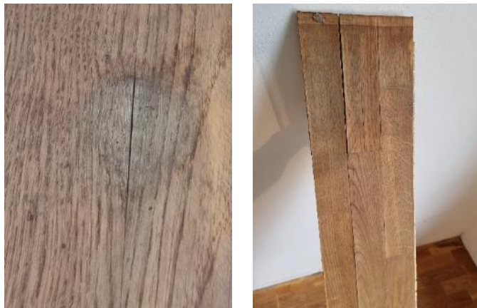
Abbildung 11: Partielle Schäden (Verfärbungen, offene Fugen und Ablösungen) an Mehrschichtparkett-Elementen
