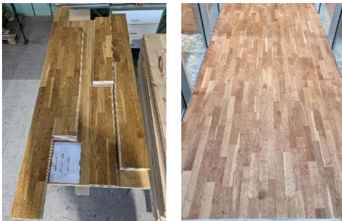
Abbildung 14: Überarbeitete (linkes Bild) und neu verlegte Parkettdecken (rechtes Bild)
