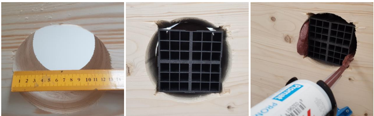
Abb. 12: Nachträglich erstellte Öffnung auf der Baustelle für die Montage eines PROMASTOP®-IM Grille-Lüftungsbausteins (Quelle: Etex Building Performance GmbH)
