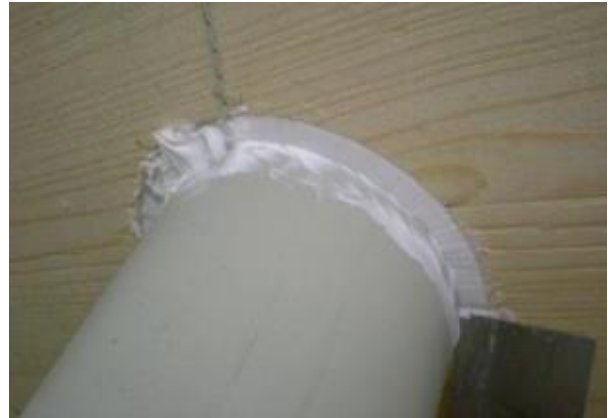
Abb. 22: Ringspalt mit Brandschutzacrylat abgedichtet
