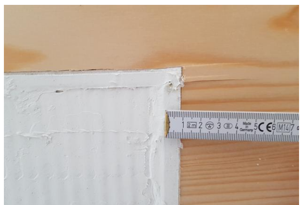
Prod. 21: Weichschott: Promat - PROMASTOP®-CA mit Laibungsverkleidung PROMATECT®-H
