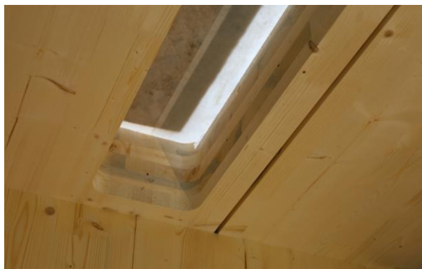
Abb. 10: Deckenausschnitt erfolgte durch Brettsperrholz-Hersteller im Werk
