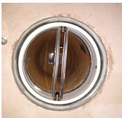
vor Beginn der Prüfung
