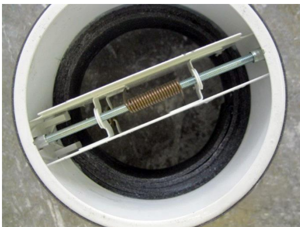
Abb. 29: Feuerschutzabschluss mit intumeszierendem Material und Verschlusselement (FLI-VE)
