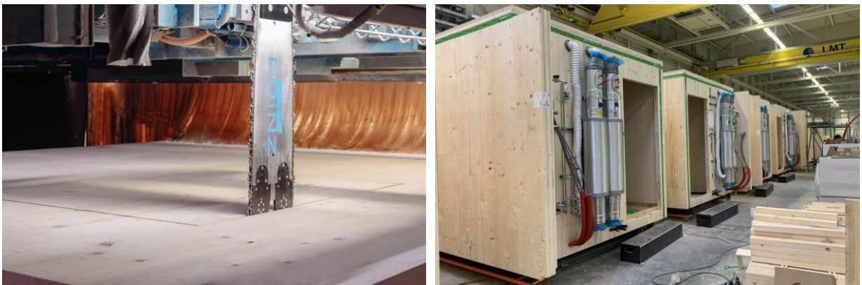
Abb. 9: CNC-Bearbeitung im Herstellwerk (Quelle: Stora Enso Oyj) und Einbau von Abschottungssystemen bei vorgefertigten Modulen
