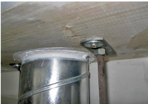
Abb. 26: Beispiel der Befestigung eines Wickelfalzrohrs in Brettsperrholz
