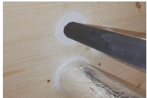
Abb. 20: Ringspalt mit Brandschutzacrylat abgedichtet
