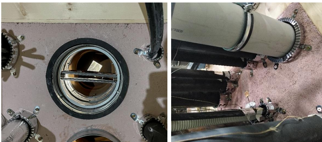
Prod. 24: Erweiterte Kombiabschottung mit Brandschutzmörtel AIR FIRE TECH - TIROTECH
