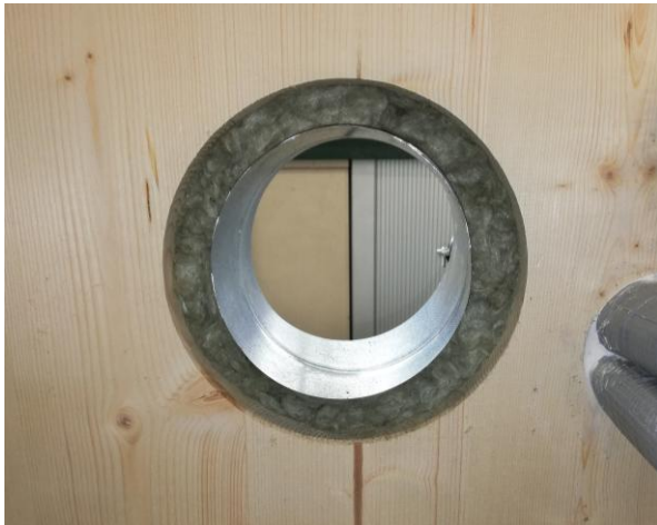
Abb. 27: Ringspalt (Abstand zwischen Brettsperrholz und Rohr) von \leq 30 mm – ausgestopft mit Mineralwolle (Schmelzpunkt \geq 1000 °C)
