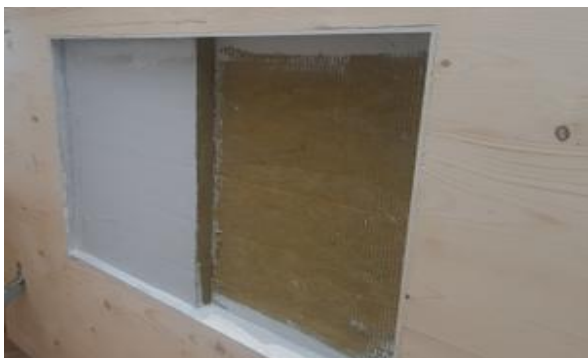
Prod. 18: Weichschott: Promat – PROMASTOP®-CA mit Laibungsbekleidung PROMATECT®-H
