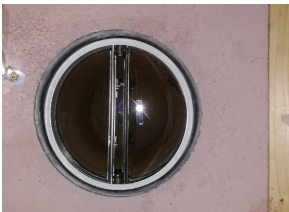
Prod. 12: Brandschutzklappe: AIR FIRE TECH – INLAP in Brandschutzmörtel AIR FIRE TECH – TIROTECH montiert
