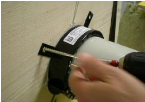
Abb. 23: Befestigung einer Brandschutzmanschette in Brettsperrholz
