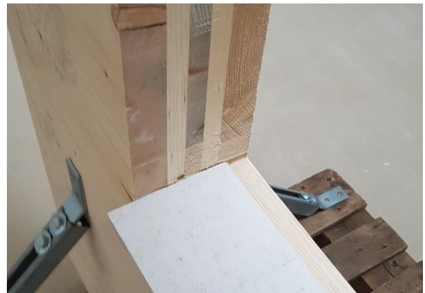
Abb. 33: exakter Ausschnitt des Brettsperrholzes
