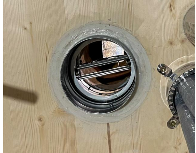
Abb. 25: Ringspalt mit Brandschutzacrylat abgedichtet
