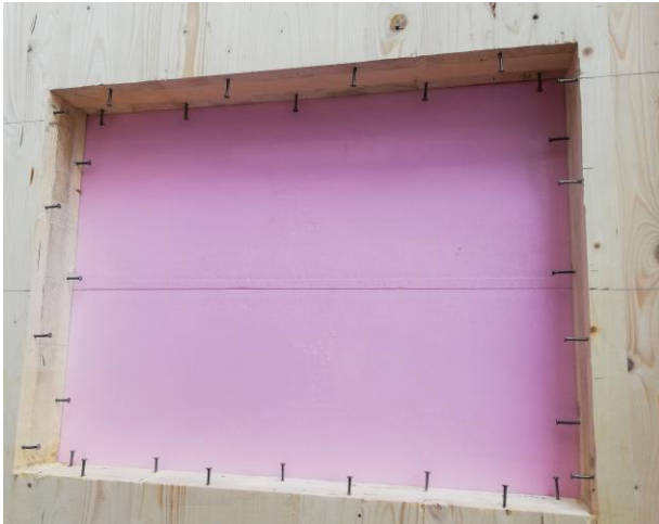
Prod. 16: Einbau eines mit Stahlnägeln gesicherten Mörtelschotts: AIR FIRE TECH – TIROTECH
