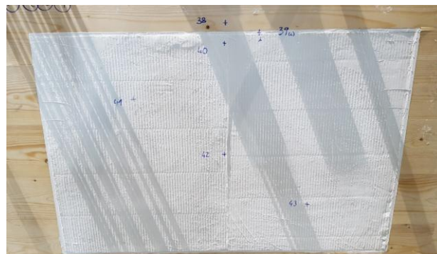
Prod. 19: Weichschott: Promat – PROMASTOP®-CA (Weichschott mit Brandschutzbeschichtung PROMASTOP®-CA)
