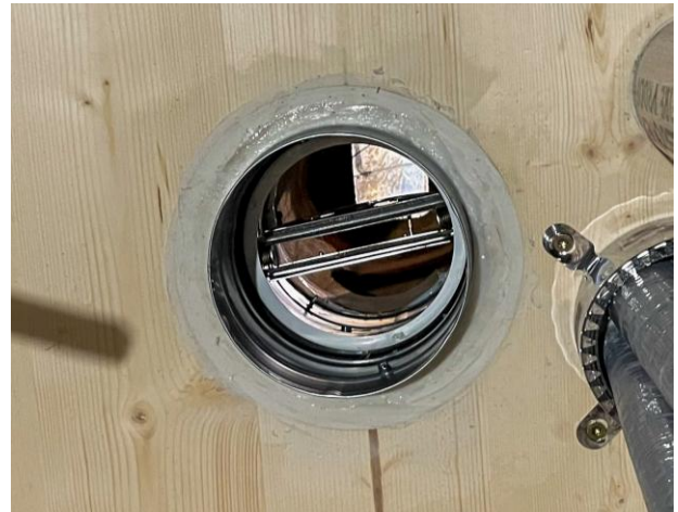
Abb. 28: Ringspalt mit Brandschutzacrylat abgedichtet
