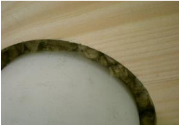
Abb. 21: Ringspalt (Abstand zwischen Brettsperrholz und Rohr) von \leq 10 mm – ausgestopft mit Mineralwolle (Schmelzpunkt \geq 1000 °C)
