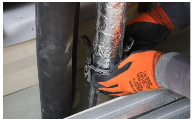
Abb. 11: Einbau der Abschottung auf der Baustelle (Quelle: AIR FIRE TECH)
