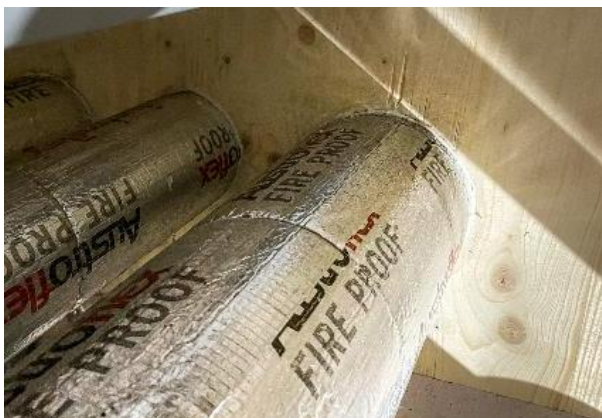
Prod. 11: Streckenisolierung: AIR FIRE TECH - FIRE PROOF
