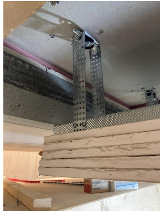
Abbildung 6: Montierte Unterdecke (mit mehreren Lagen Gipskarton) auf schallentkoppelten Direktschwingabhängern ohne Abdichtung zum Rand
