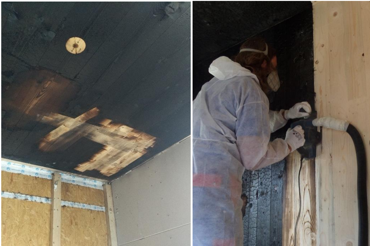
Abbildung 10: Sanierung der Holzoberfläche mittels Hobeln und Schleifen
