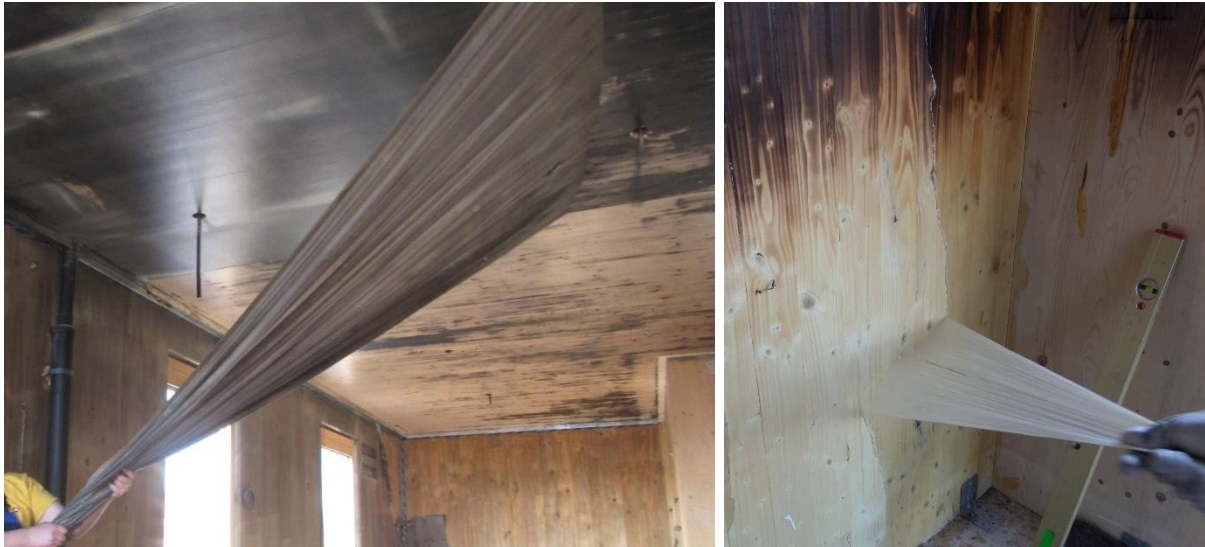
Abbildung 8: Oberflächliche Reinigung durch das Peel-Off Verfahren (auch Latex-Verfahren genannt); Ruß und weitere Schmutzablagerungen werden im Peeling-Film gebunden und danach abgezogen
