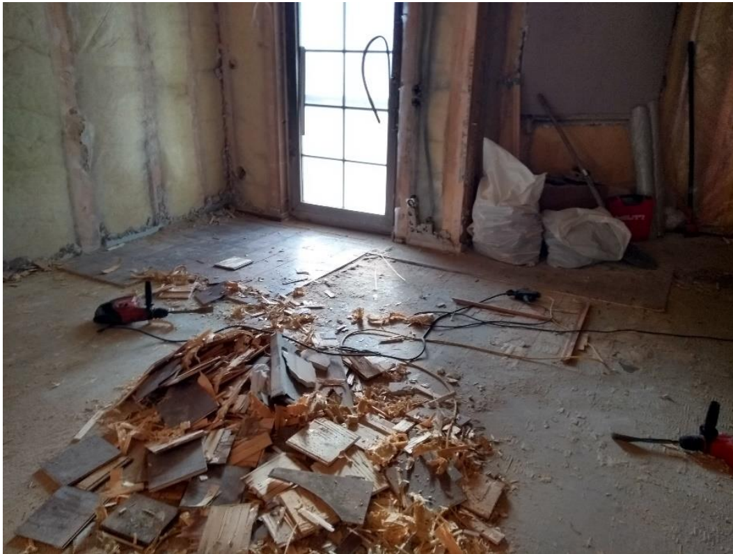
Abbildung 6: Entfernen des Fußbodenaufbaus
