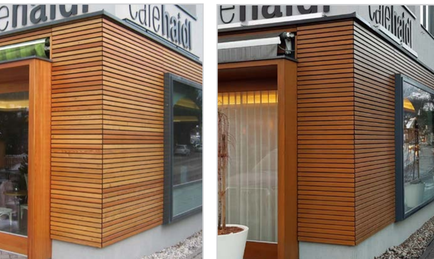
Transparent beschichtete Lärchenholzfassade: links Neuzustand, rechts 10 Jahre später. Trotz Farbtonänderung, u. A. aufgrund eines Wartungsanstrichs, ist die Farbe nach wie vor gleichmäßig
