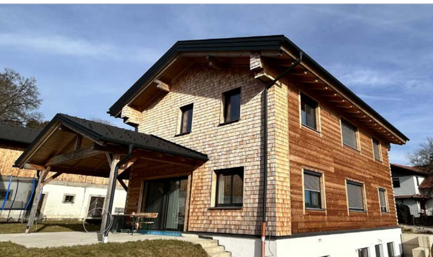
Blockhaus mit vorgesetzter Schindelfassade auf der Wetterseite
