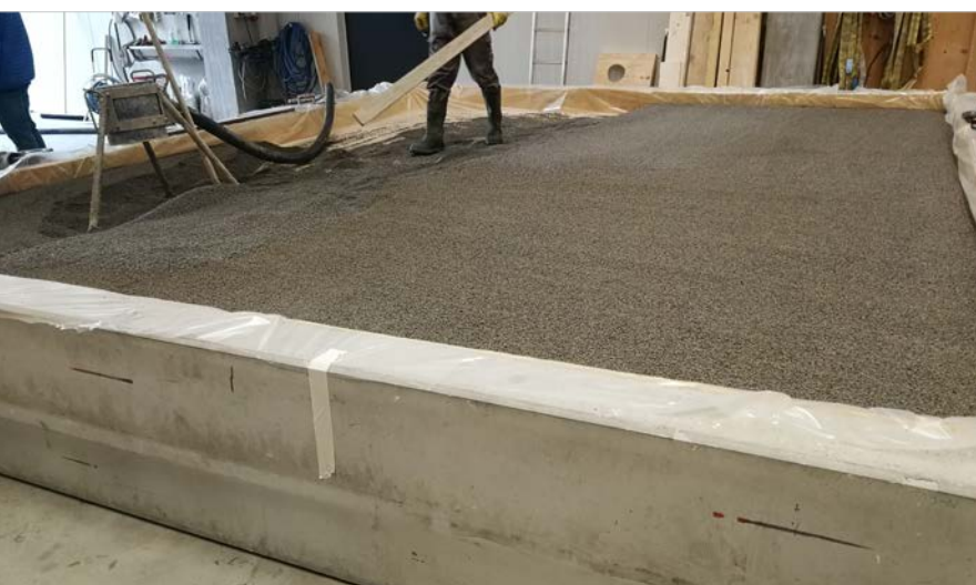
Einbringen einer elastisch gebundenen Splittschüttung mittels Estrichpumpe auf die BSP-Rohdecke
