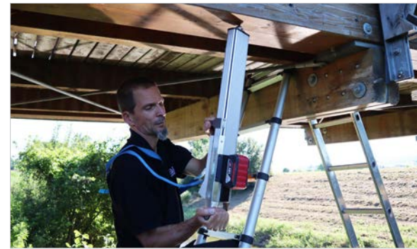
Bohrwiderstandsmessung mittels Resi PD300 im Praxiseinsatz
