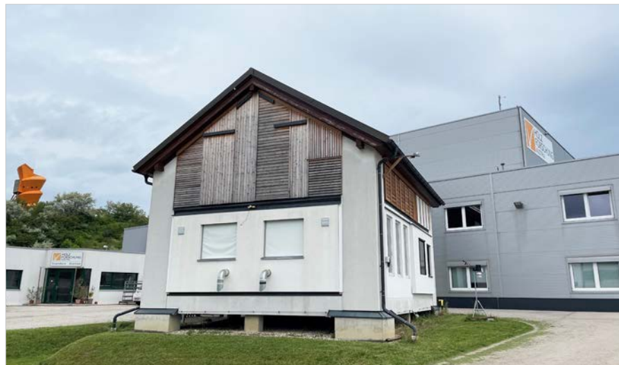
Bauphysikalisches Forschungshaus der Holzforschung Austria am Standort Stetten für die Raumklimauntersuchungen im Projekt ReactTimber
