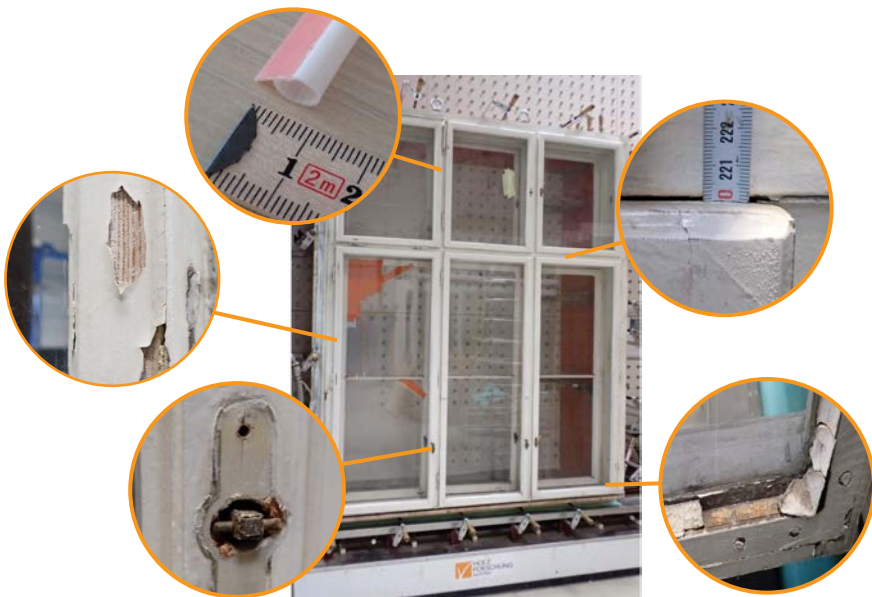
Bestandskastenfenster liefern viele Ansatzstellen für eine Sanierung oder ein Upgrade, um sie modernen Standards näher zu bringen
